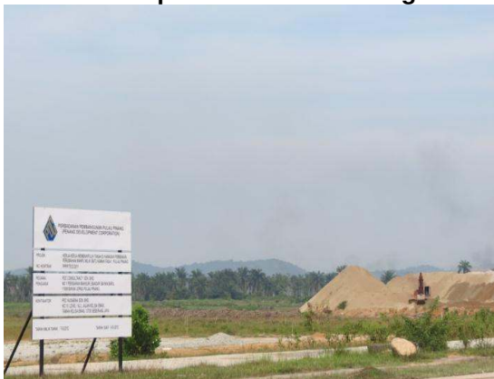
Gambar 3.5 Kawasan Cadangan Projek Pembinaan Rumah Mampu Milik Belum Dibangunkan
