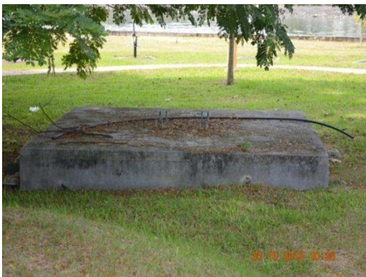
Gambar 4.9 Keadaan Tapak Menara Telekomunikasi Yang Tidak Beroperasi
