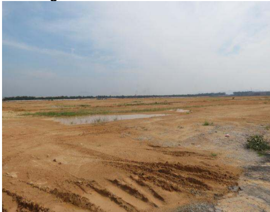
Gambar 3.3 Kawasan Cadangan Projek Pembinaan Kilang Dalam Proses Perataan Tanah
