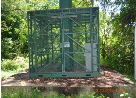
Gambar 4.7 Keadaan Tapak Menara Telekomunikasi Yang Tidak Beroperasi
