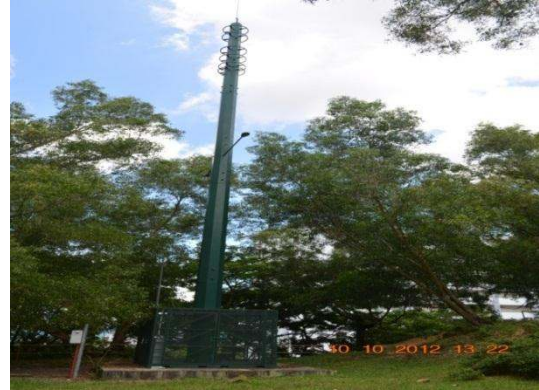
Gambar 4.8 Keadaan Tapak Menara Telekomunikasi Yang Tidak Beroperasi
