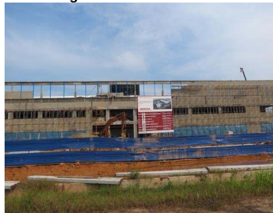
Gambar 3.6 Kawasan Cadangan Projek Pembinaan Kilang Dalam Proses Pembinaan
