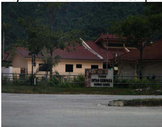
Gambar 3.13 Projek Perumahan Taman Intan Cempaka
